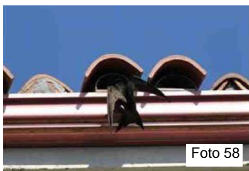
Foto 58 - Un'altra soluzione collaudata e quindi validata, consiste nel realizzare strette cassette nido per rondoni, posizionate in modo che siano appoggiate sulla grondaia e infine coperte da 2 coppi.
