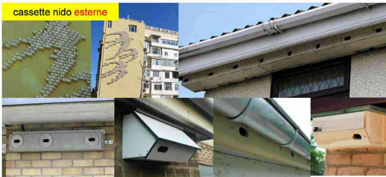
Foto 62 - Nel collage sono presenti alcune tipologie d'intervento che favoriscono la nidificazione dei rondoni.
