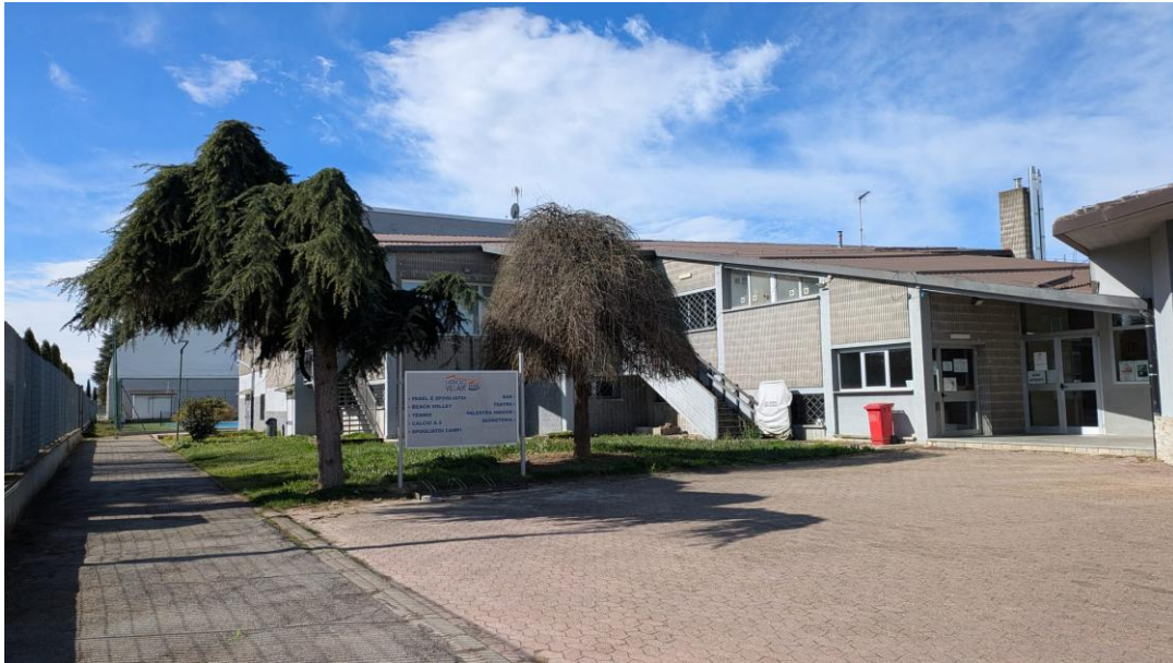
Fig. 13: Esterno ingresso principale struttura
