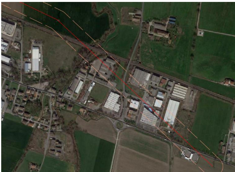
Figura 1.1.12 - Inquadramento su foto aerea (Google Earth – acquisizione immagine 18-03-2020) delle porzioni di edifici interessati dalle distanze di prima approssimazione della linea AAT 380 kV nel contesto artigianale in località Sanguinaro (fuori scala).
