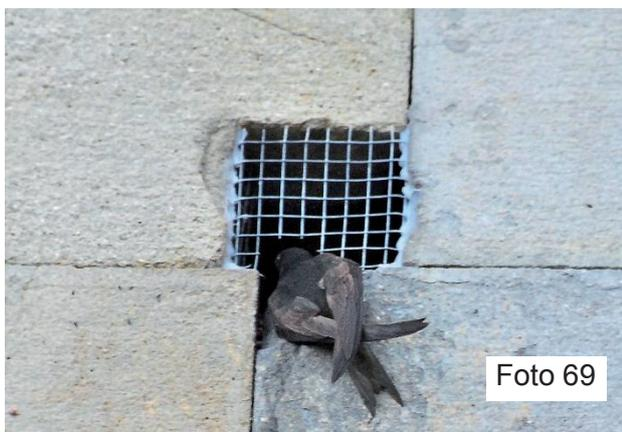
Foto 69 - La reticella così applicata impedisce l'ingresso ai colombi, la consente ai rondoni ed ai chiroterri, ma non è scevra di pericoli. I punti di taglio della rete presentano punte che possono ferire i volatili o danneggiare il piumaggio nel rondone o le membrane nei chiroterri. È una soluzione pericolosa.
