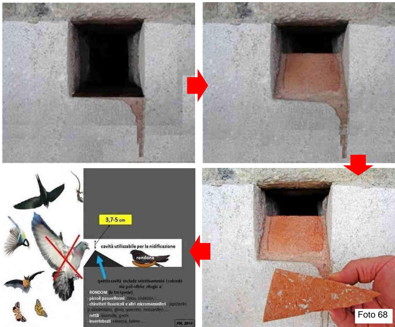
Foto 68 - Nel collage di foto è illustrato il principio dell'esclusione selettiva dalle buche pontaie di specie indesiderate per favorire le specie desiderate. Una pietra tagliata in modo asimmetrico, a formare un triangolo rettangolo con un cateto doppio dell'altro, viene murata a filo dell'ingresso di una buca pontaia. Il cateto corto guarda verso l'esterno, l'ipotenusa è la base. L'altezza del passaggio varia da 3,7 a 5 cm.
