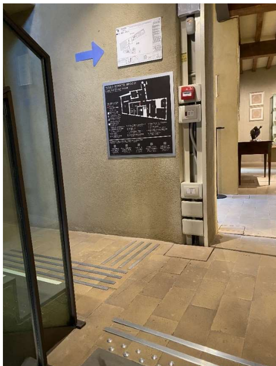
Figura 11: percorsi tattilo plantari, mappa tattile e planimetria con piano di emergenza
