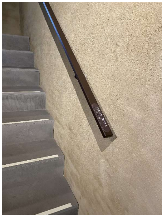
Figura 7: la scala interna. Corrimano con targhetta con testo in rilievo e braille, strisce di segnaletica orizzontale apposte sui gradini
