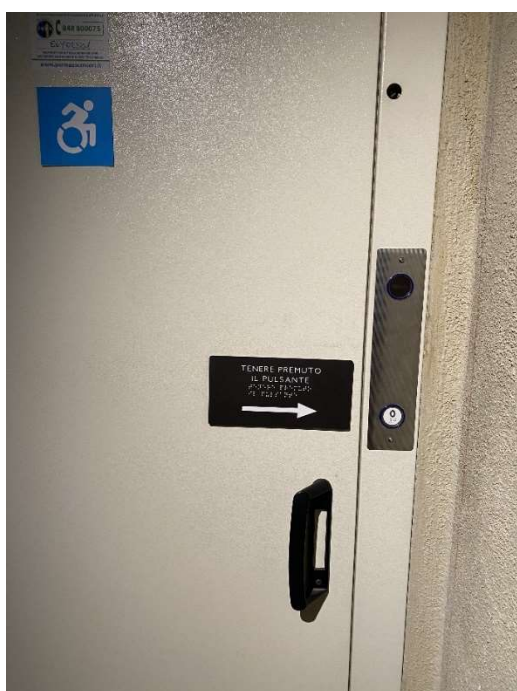
Figura 10: targa con testo a rilievo e Braille per descrivere il funzionamento della piattaforma elevatrice
