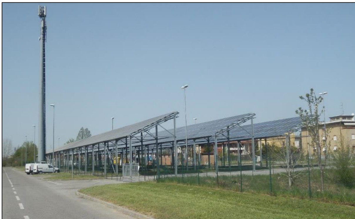
Figura 6.3.1 – Impianto fotovoltaico pubblico realizzato su pensiline
