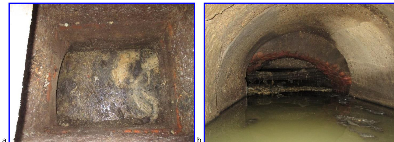
Figura 3: a) camera n°571 di via Pasubio e b) vista tubo da cam. n°1103 di via Roma.
