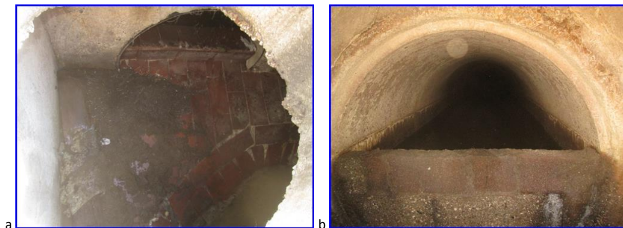
Figura 6: a) partizione n°767 di via Cavour, b) soglia in camera n°768 di via Cavour.
