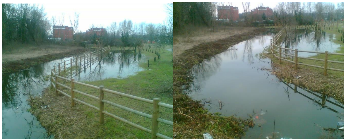
Figura 19: tracimazione cavo Pozzo
