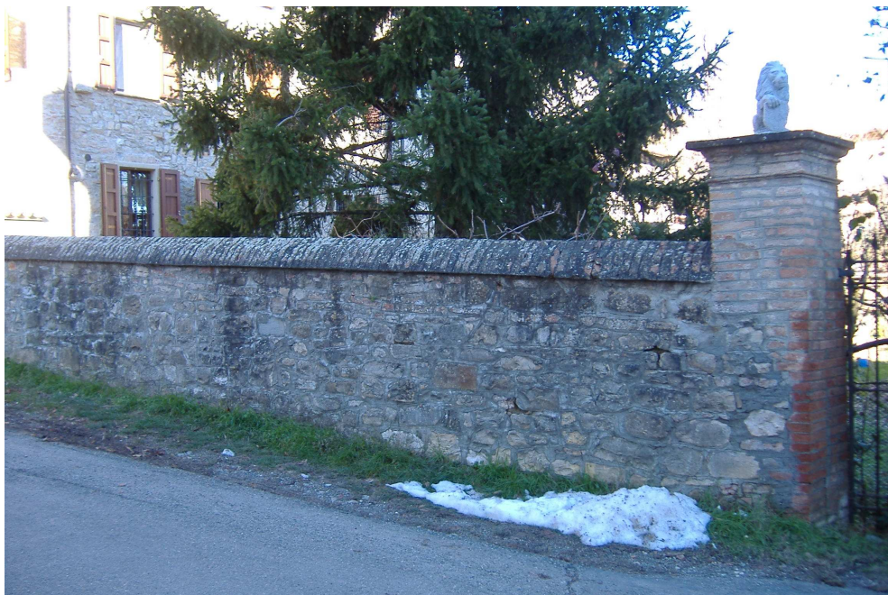
Foto n.8 (mura esterna lato sud)
