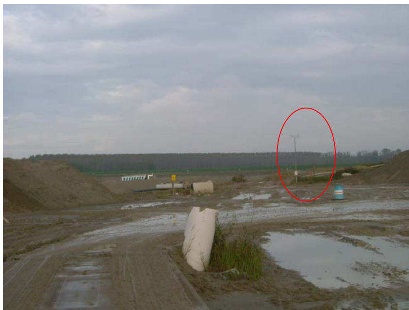
Foto 3: antenna per la comunicazione radio all'interno della cava
