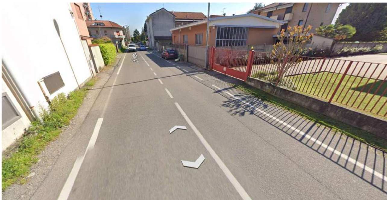
Tratto di via Rossini interessato dall'intervento
