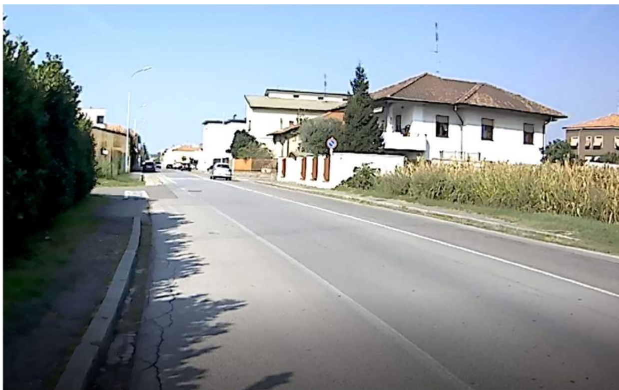
Via San Carlo nei pressi dell'inizio dell'intervento (intersezione con via Caprera)
