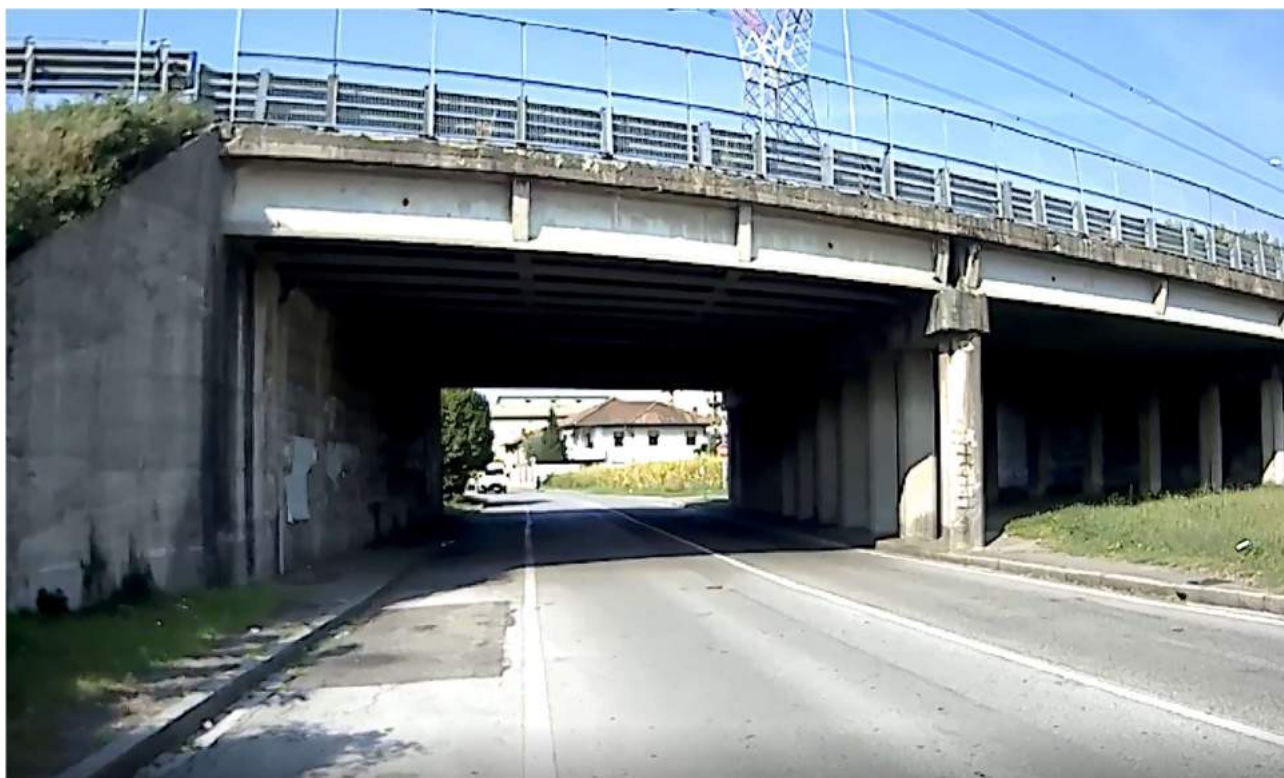
Via San Carlo nei pressi del cavalcavia della SP35
