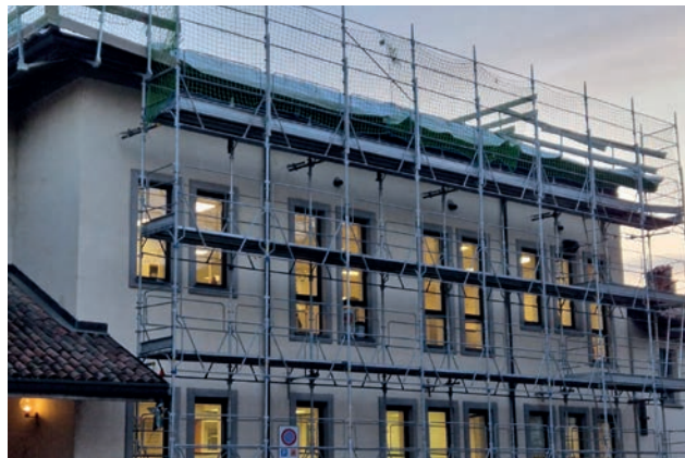
Lavori in corso per lo Sportello
