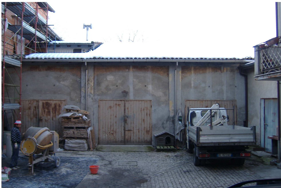
Foto n.8 (fronte interno nord)
