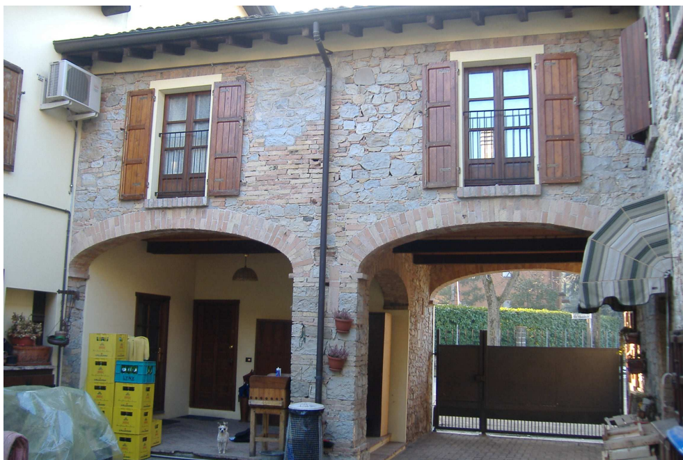
Foto n.5 (fronte interno est)
