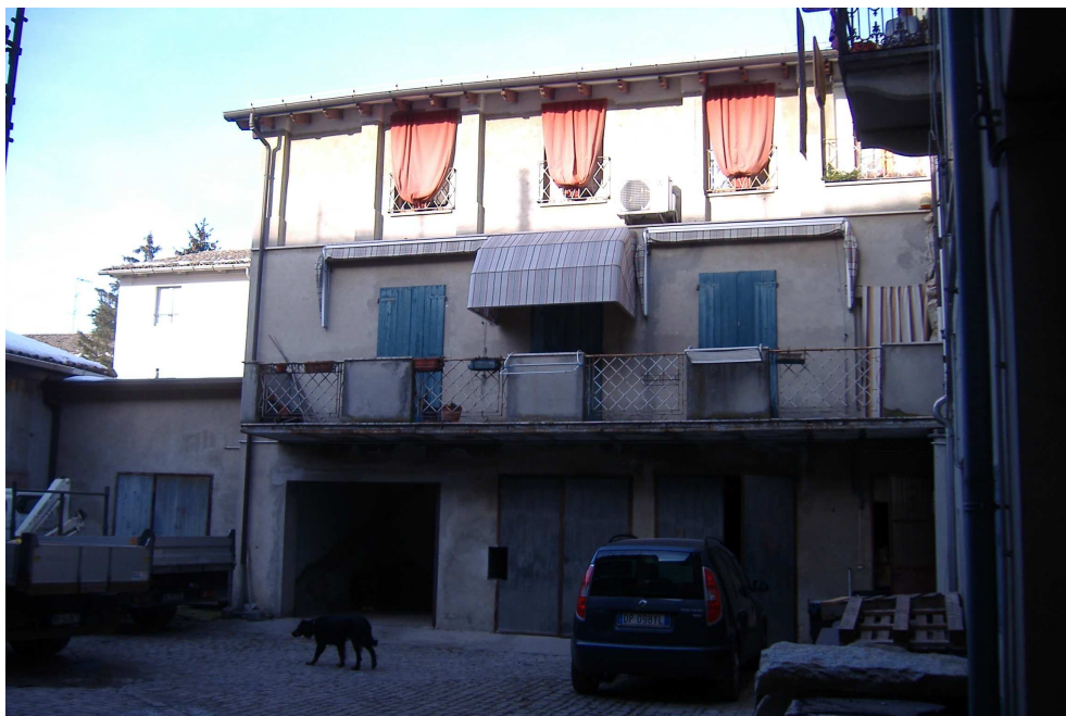
Foto n.9 (fronte interno est)
