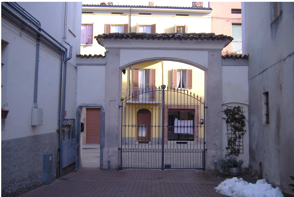
Foto n.5 (vista ingresso dal cortile)
