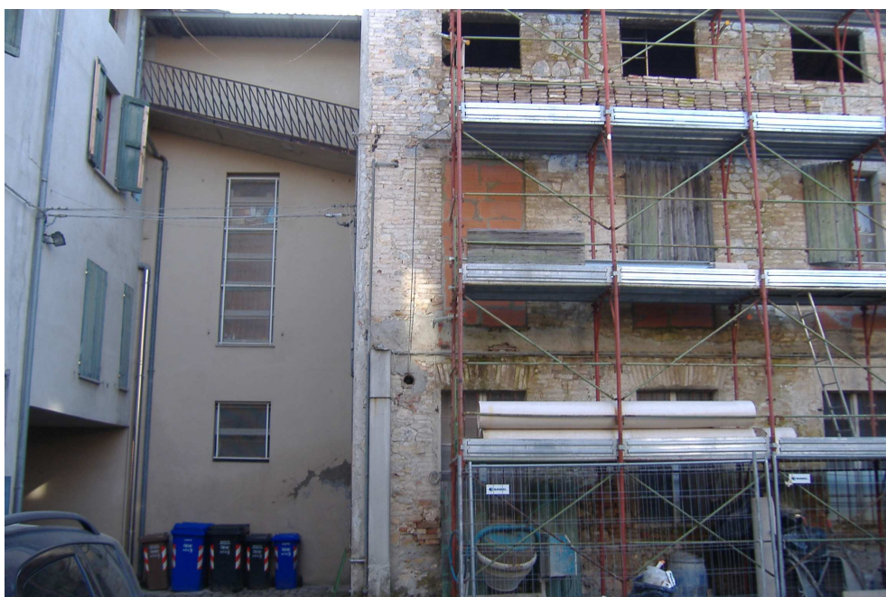
Foto n.4 (fronte interno ovest)
