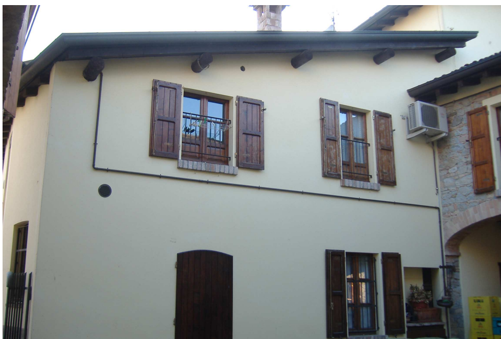
Foto n.6 (fronte interno nord)
