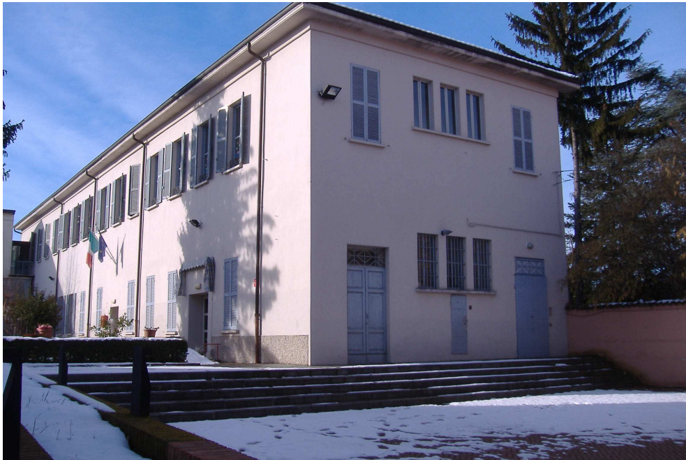
Foto n.10 (fronte interno nord-est)
