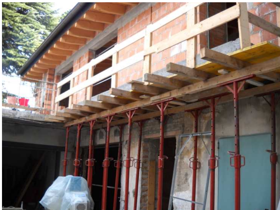
Foto n.10 (fronte interno ovest)
