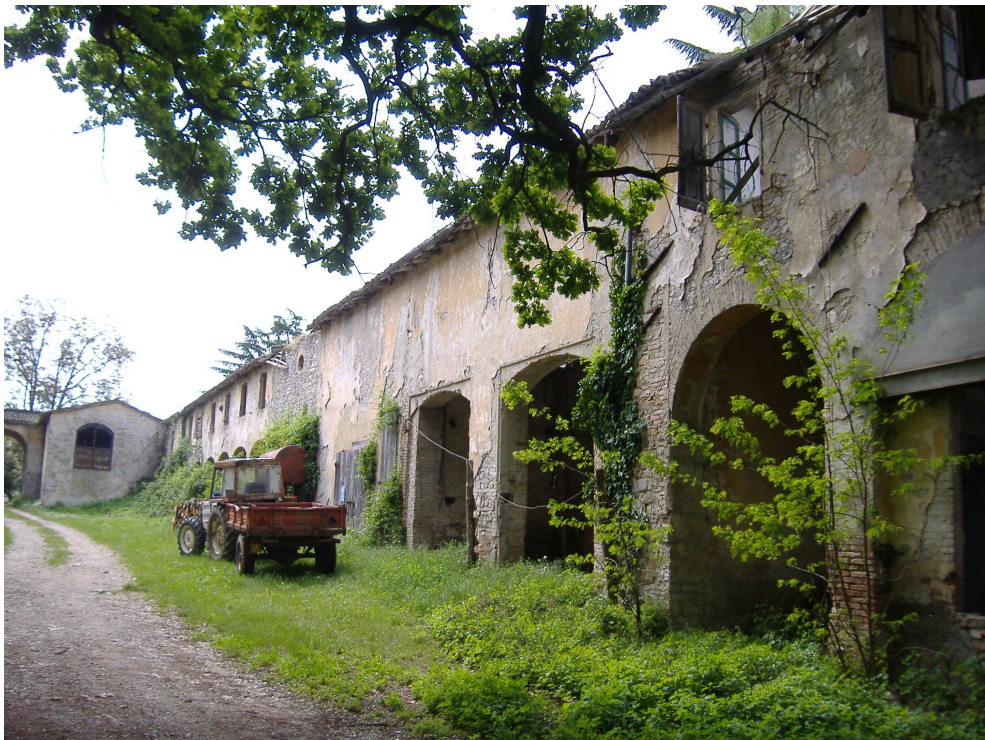
Foto n.6 (fronte interno nord-est)
