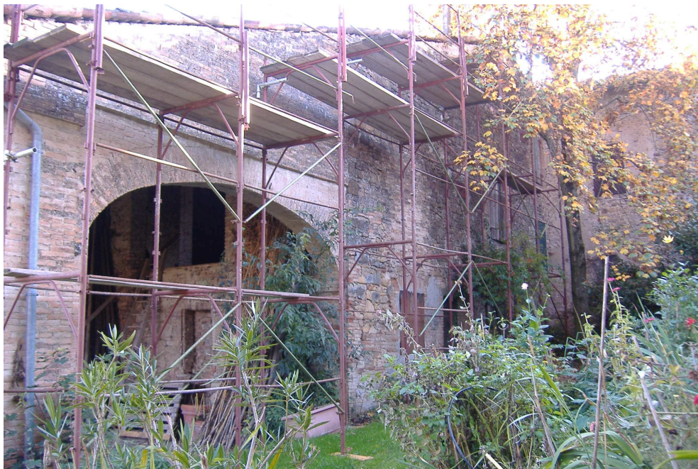
Foto n.10 (fronte interno sud-ovest)
