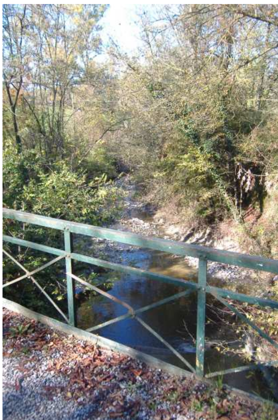
Foto n.2 (ponticello di accesso sul T. Scodogna)
