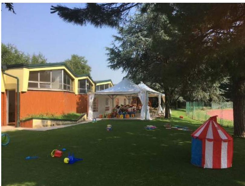
Fotografia dell'intervento completato.
