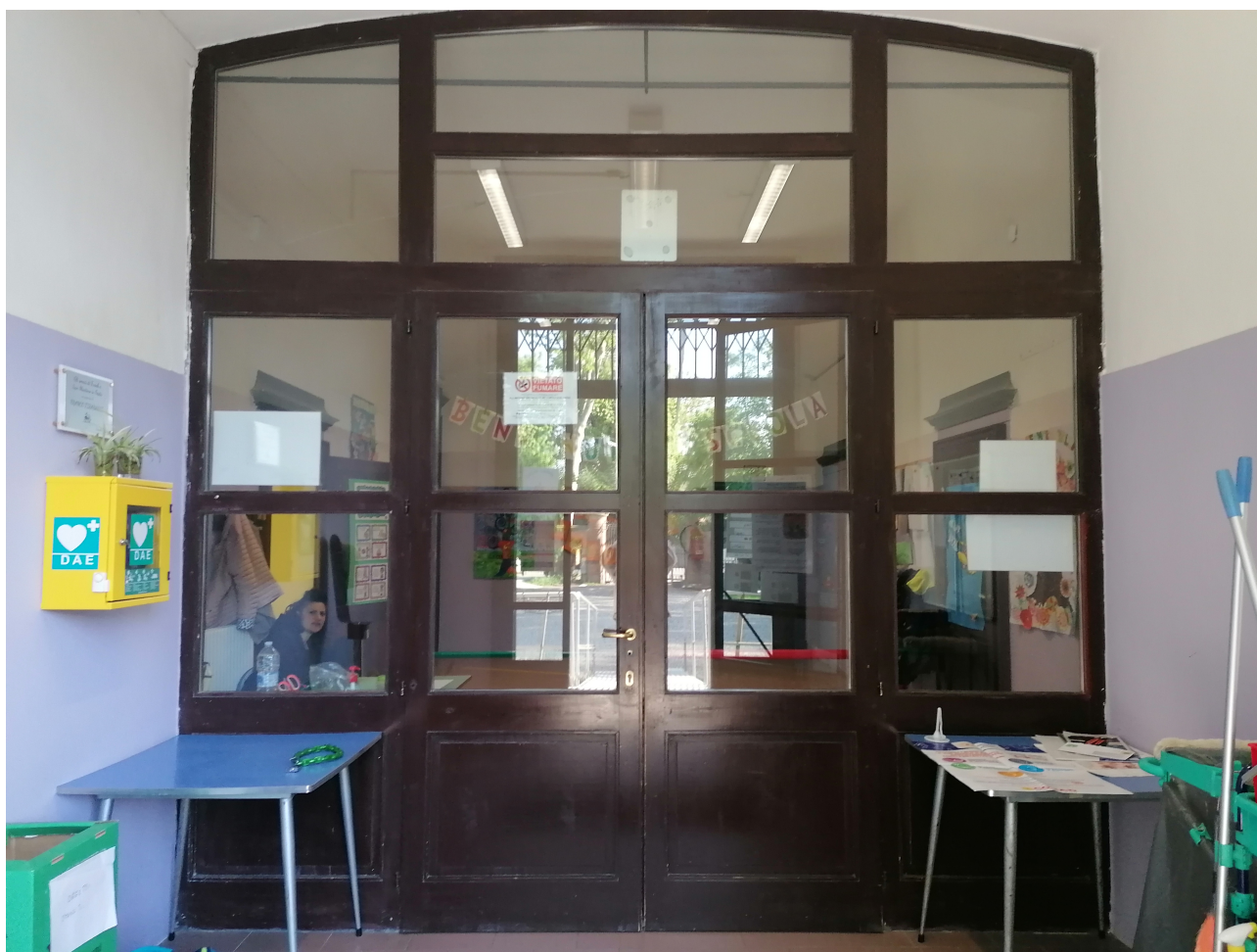
2. Vetrata interna di accesso al piano terra.
