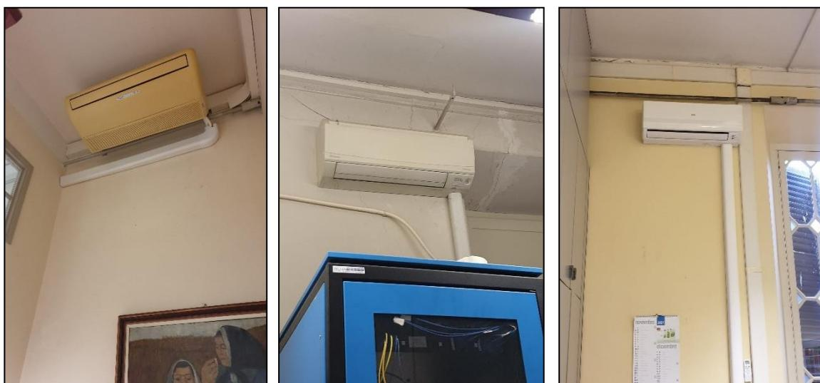
Le opere di installazione saranno corredate di opportuni supporti, apparecchi integrativi e lavori sostanziali, quali le opere di muratura, staffaggio ed ancoraggio delle macchine, centraline di controllo per la gestione delle funzioni degli impianti, tubazioni per la mandata del gas refrigerante e per la raccolta delle acque di condensa, nonché la realizzazione di idoneo impianto elettrico di alimentazione dedicato.
