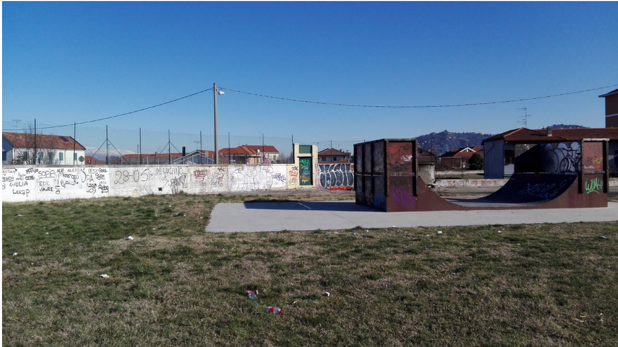
Figura 1: Piastra in cemento armato e rampa skater in ferro
