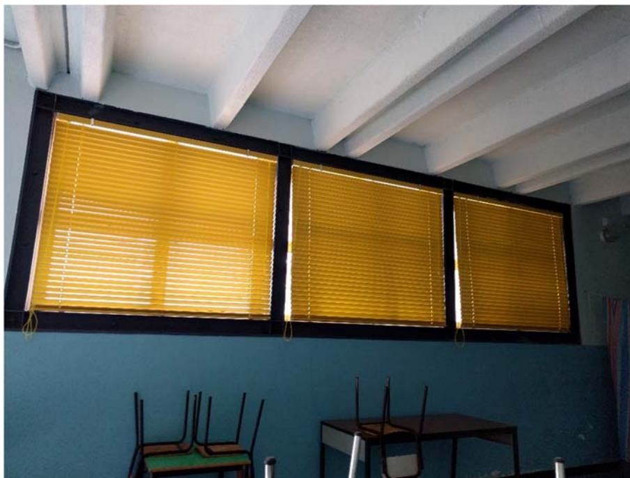
Particolare cerchiature con profilati in acciaio
