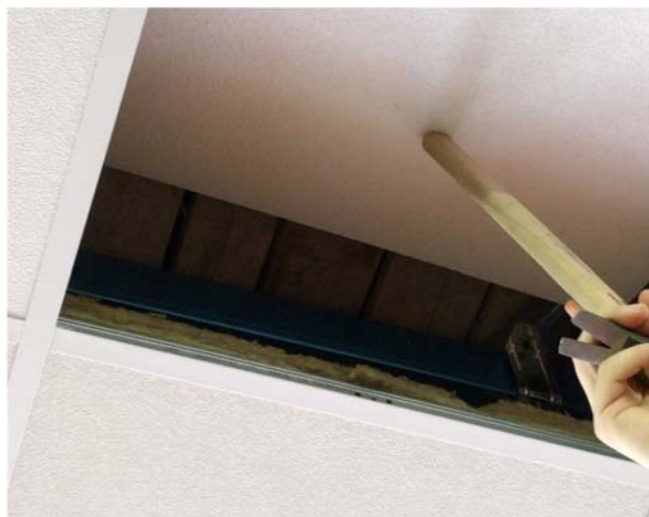
Particolare assi di legno sopra controsoffitto
