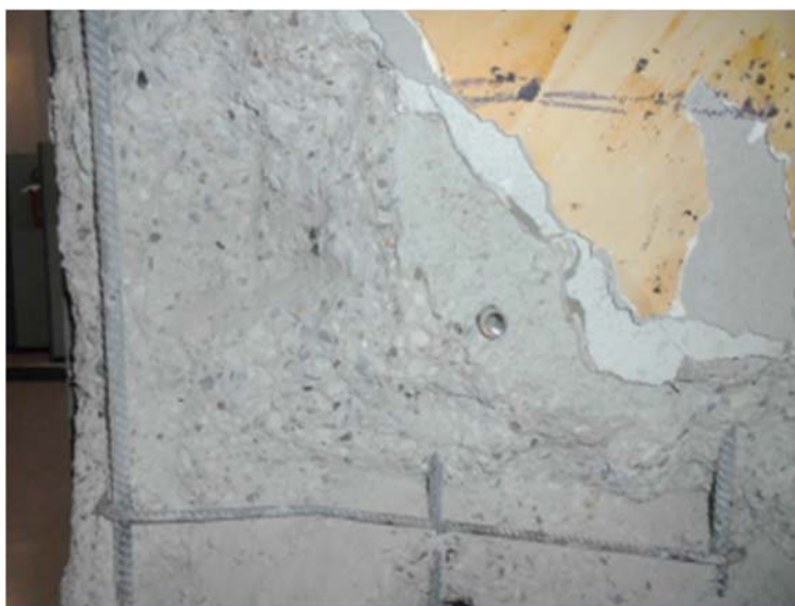
Il sondaggio nel pilastro
