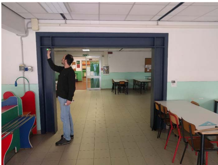
Particolare profilati in acciaio nella mensa
