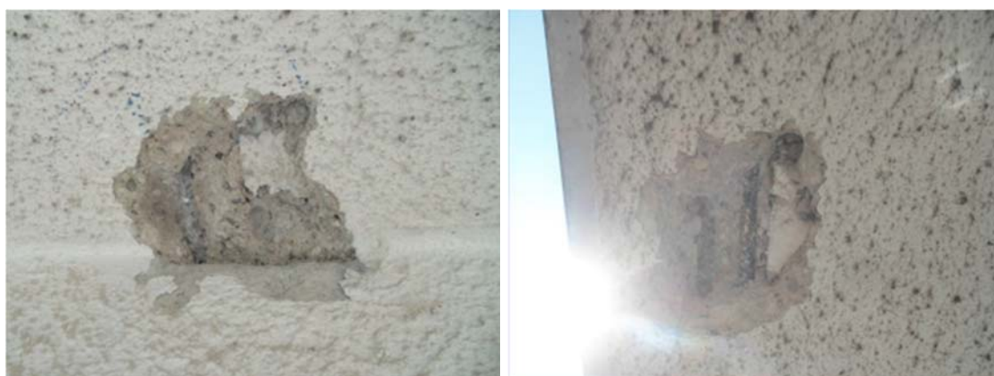
Il sondaggio nel cornicione
