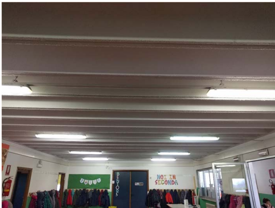
Vista solaio con nervature semicircolari
