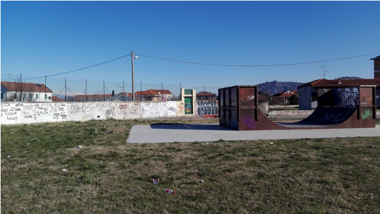
Figura 2: Piastra in cemento armato e rampa skater in ferro
