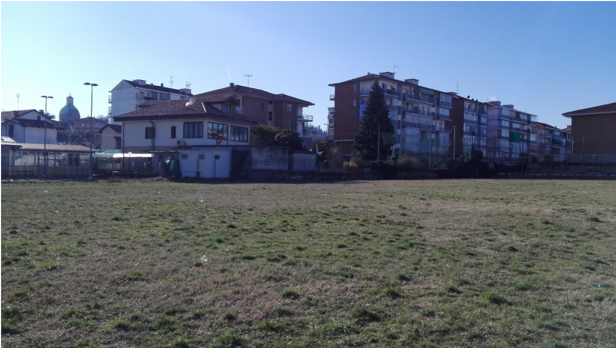
Figura 4 inquadratura sud con edifici residenziali limitrofi
